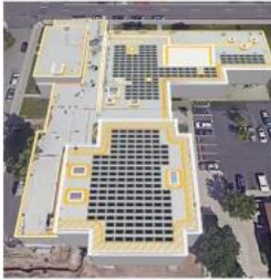
100kW Solar Array
